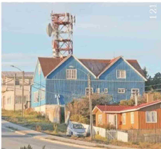
Ante una interrupción de Internet, hoy Porvenir no posee sistema de redundancia, aunque si tiene un “Plan B”, que es una conexión por microondas (foto), con una muy mínima capacidad de ancho de banda.
