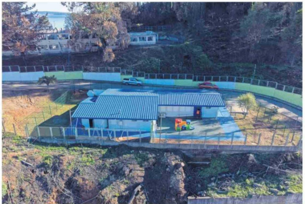
La estructura cuenta con accesibilidad universal y aislación térmica.
