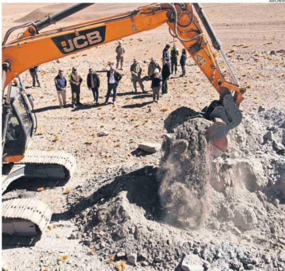
HOY COMENZARÁN LOS TRABAJOS DE LA BRIMOT EN LA CONSTRUCCIÓN DE LA ZANJA EN LA COMUNA DE OLLAGÜE.
