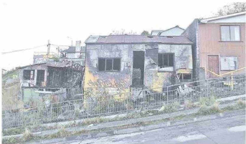
La propiedad principal fue destruida por la acción del fuego. Una segunda vivienda, en el mismo terreno, había corrido la misma suerte tiempo atrás.
