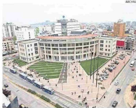
EDIFICIO DE LA CORTE DE APELACIONES DE CONCEPCIÓN.
