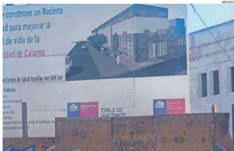
LAS OBRAS INCONCLUSAS DEL CESFAM SURPONIENTE PRETENDEN REACTIVARLAS DURANTE ESTE AÑO.
