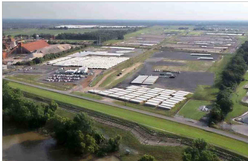
La planta de Air Products a lo largo del río Mississippi en la Parroquia de Ascension, Luisiana.
