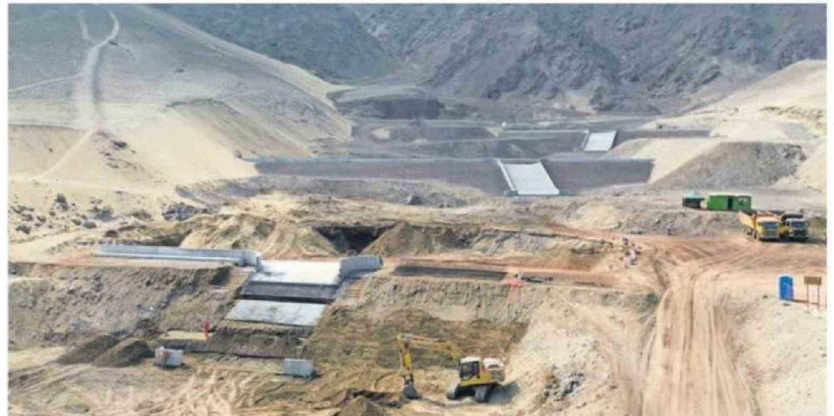
LAS OBRAS BUSCAN CONTENER MATERIALES COMO ROCAS Y LODO EN CASO DE FUERTES LLUVIAS.
