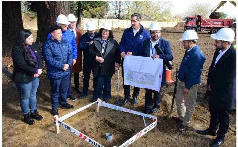
CON LA COLOCACIÓN de la primera piedra, se iniciaron las obras de construcción del Cosam en Los Ángeles.
