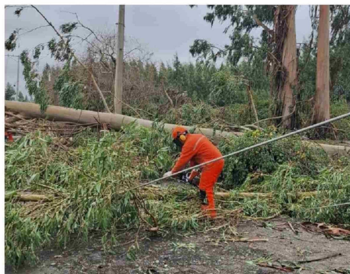
REGISTROS DE LOS TRABAJOS de despeje efectuados cerca de la villa.
