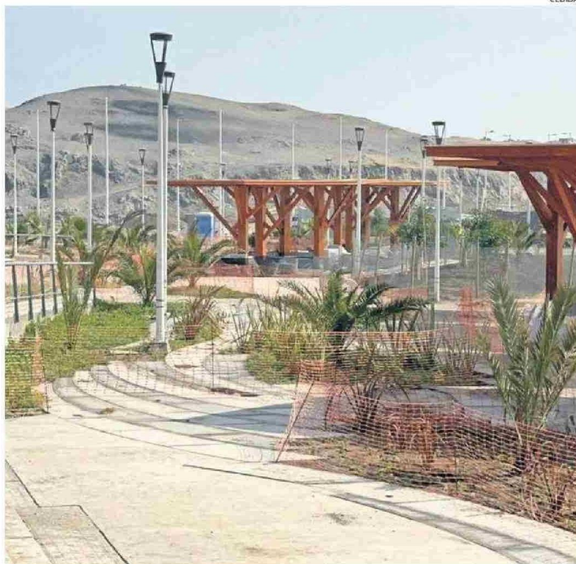
LAS OBRAS YA TENDRÍAN UN 90% DE AVANCES.
