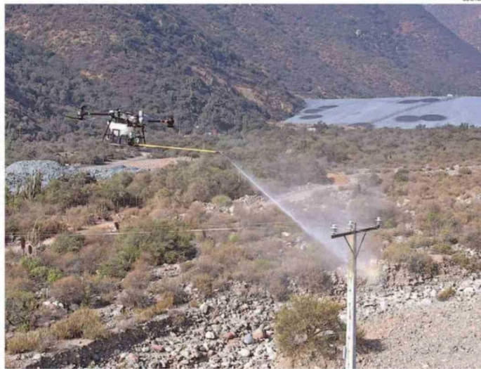
ESTE TIPO DE POSTES DE DISTRIBUCIÓN FUERON LOS BENEFICIADOS CON LA NOVEDOSA LIMPIEZA.
