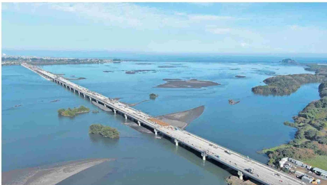
El viaducto tendrá 2,5 kilómetros de extensión sobre el río Biobío, siendo el más extenso del país.
