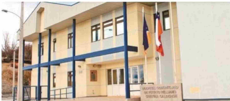
Hospital Comunitario Cristina Calderón de Puerto Williams.
