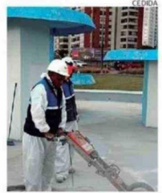
TRABAJOS EN PILETA SECTOR SUR.
