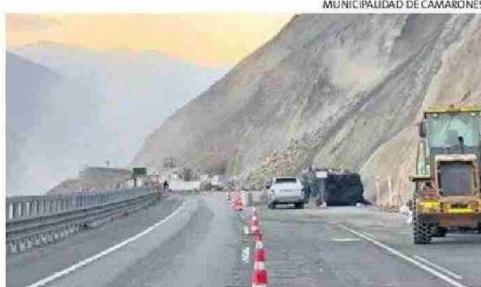
KM 1.968 DE LA RUTA 5 NORTE ES UNO DE LOS MÁS AFECTADOS.
