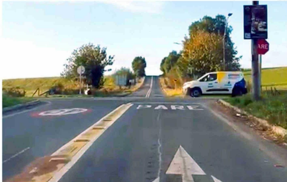
ESTA ES LA VISTA QUE TIENEN LOS CONDUCTORES QUE SE DESPLAZAN HACIA EL NORTE POR LA V-56, AL LLEGAR AL CRUCE CON LA RUTA V-500.
