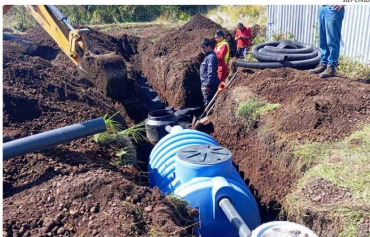
AYER EL SLEP REALIZÓ OBRAS DE INSTALACIÓN DE FOSA EN EL ESTABLECIMIENTO.
