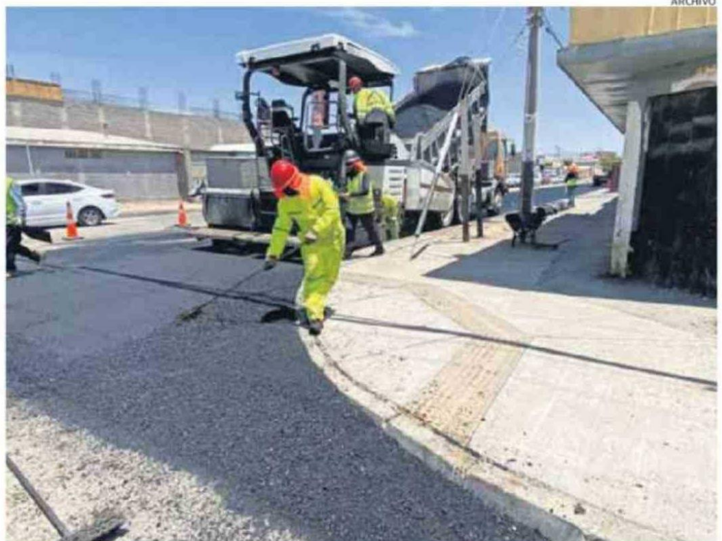
SE INFORMÓ QUE ALGUNOS TRAMOS DE PAVIMENTACIONES PARTICIPATIVAS YA COMENZARON TRABAJOS.
