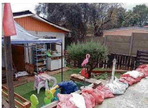
EN EXPRESOS VIÑA AGUAS SRVIDAS INGRESRON A UNA VIVIENDA.
