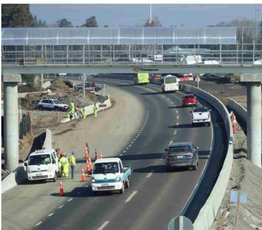
EL ALCALDE ALFREDO PEÑA, de Negrete, valoró la conectividad que traerá la autopista, pero pidió mayor fiscalización para evitar que se repitan trabajos inconclusos.
