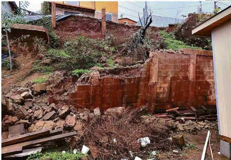
EN EL SECTOR DE VILLA ROGERS HUBO ALGUNOS DESLIZAMIENTOS DE TIERRA Y SE CAYÓ UN MURO.
