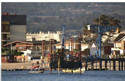
OBRAS. Unas semanas atrás se instaló una plataforma que perforó el suelo marino del sector donde se planea construir un muelle.
