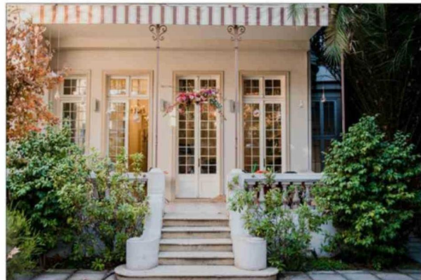
La fachada fue restaurada con lijas. Se reconstruyeron piezas faltantes.
