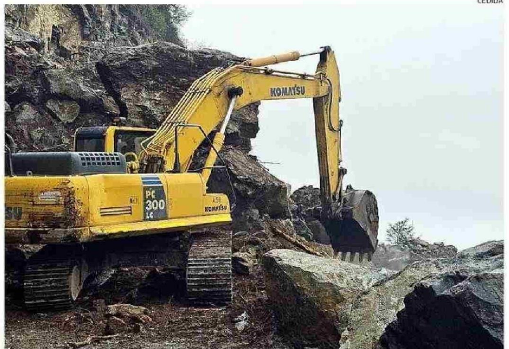
CON MAQUINARIA PESADA SE TRABAJABA AYER EN ESTE PUNTO DE LA REGIÓN DE LOS LAGOS.
