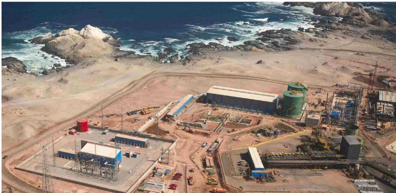
La estación de bombeo 1, ubicada en el Puerto de Collahuasi, fue la primera en ser energizada.
