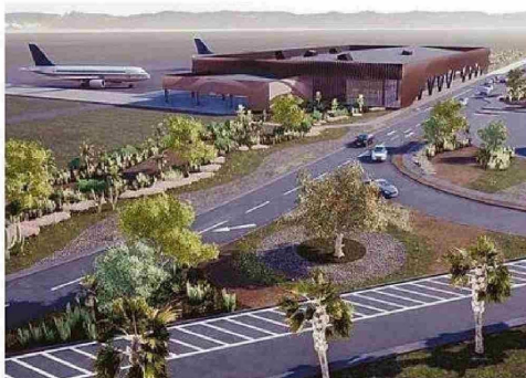
GOBIERNO HABÍA ANUNCIADO OBRAS PARA FINES DE ESTE AÑO.
