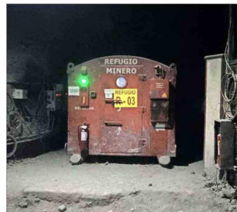
El Teniente , ubicada en la comuna de Machalí, tiene refugios en caso de emergencia en la mina subterránea.
