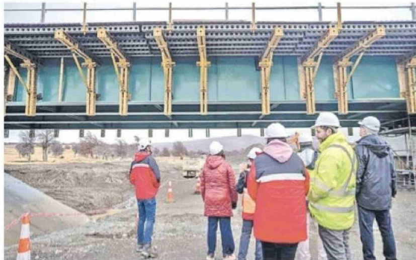
La obra tendrá un costo de $24 mil millones. Considera 4 kilómetros de mejoramiento de sus accesos, rectificando la curva y contracurva existente en la Ruta 9.
