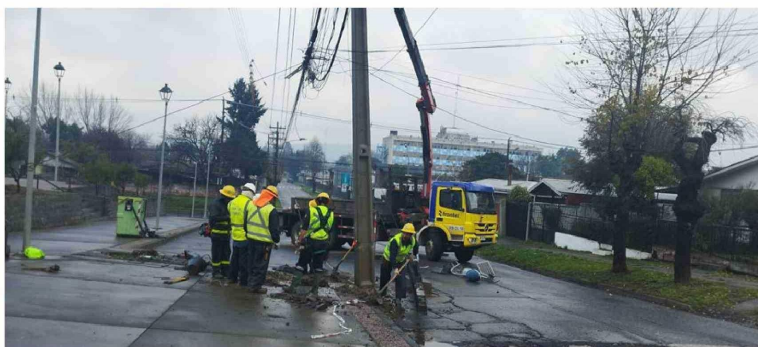
Brigadas de Frontel trabajando
