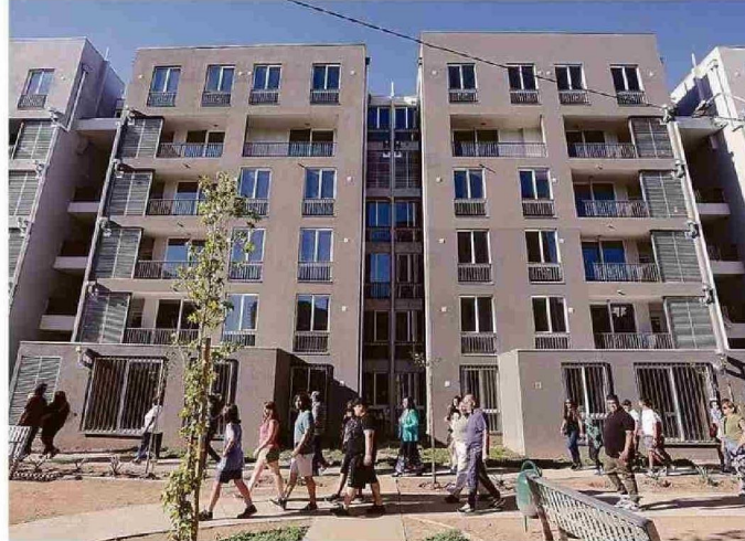
DESDE EL SERVIU VALPARAÍSO DESCARTARON QUE EXISTA UNA RALENTIZACIÓN DE PAGOS.
