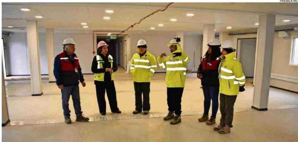
LA EMPRESA A CARGO DEL PROYECTO ES LA CONSTRUCTORA BELFI S.A. Y EL PLAZO PARA TERMINAR LOS TRABAJOS VENCE A FINES DE 2026.
