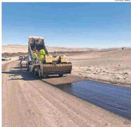
LAS AUTORIDADES AFIRMARON QUE OBRAS CONCLUYEN ESTE MES.
