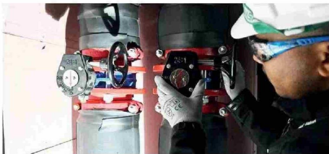
Desde febrero estamos trabajando en la modernización del sistema de climatización del principal recinto de salud de la Macrozona Norte de Chile.
