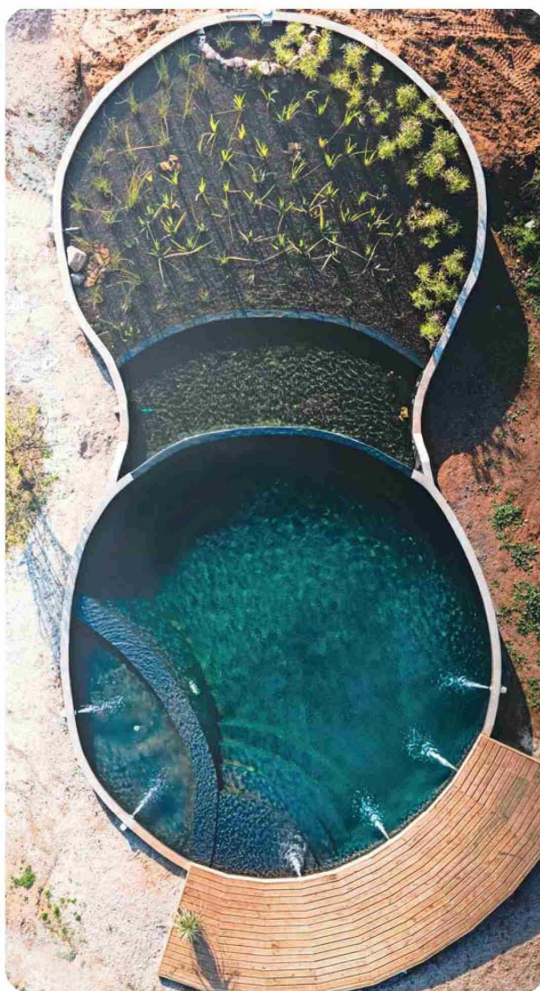
Este tipo de piscinas se construyen para que formen parte del entorno, sin alterarlo.
