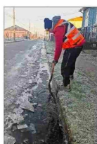
Ola de frío deja temperaturas récord que causan problemas en servicios básicos y vías. | C7
