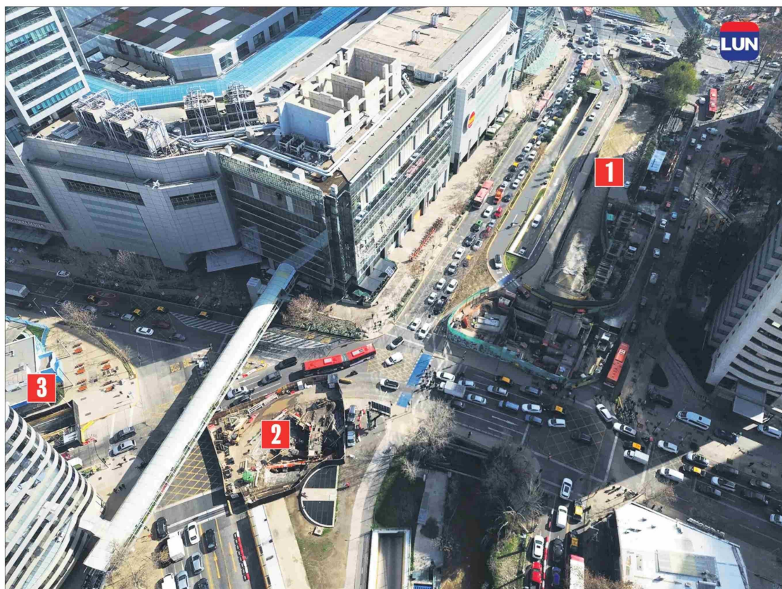
1. Futura estación del Teleférico. 2. Pique para la línea 7 del Metro. 3. Nueva rampa de salida del Costanera Center hacia la calle Holanda.
