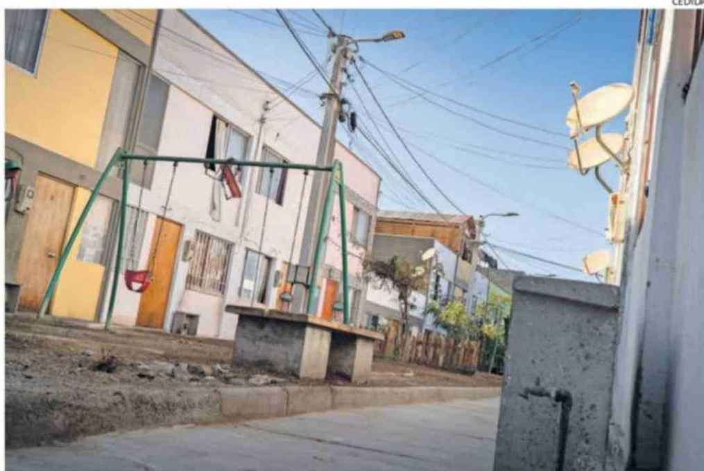
48 VIVIENDAS TENÍAN PROBLEMAS DE FUGA DE AGUA.
