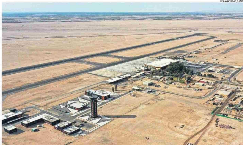
LA ACTUAL INFRAESTRUCTURA DEL AEROPUERTO CHACALLUTA.
