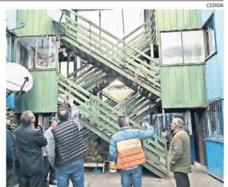
LAS ESCALERAS SERÁN REPARADAS EN LOS EDIFICIOS
