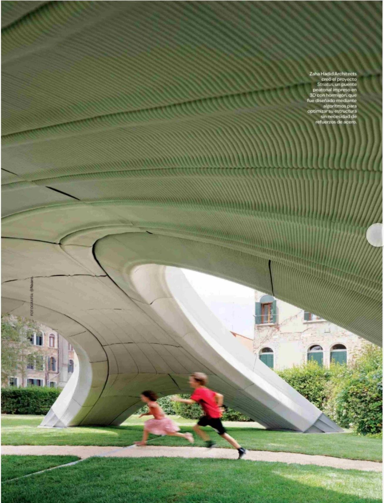
Zaha Hadid Architects creó el proyecto Stratus, un puente peatonal impreso en 3D con hormigón, que fue diseñado mediante algoritmos para optimizar su estructura sin necesidad de refuerzos de acero.
