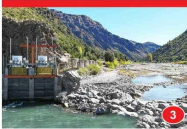
Finalizan obras del sistema de riego Melado en el Maule Sur
