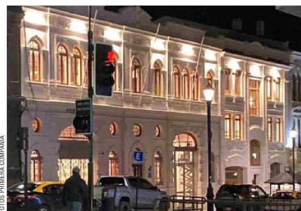
El remodelado cuartel, ubicado en calle Roca, recuperó toda la fachada.
