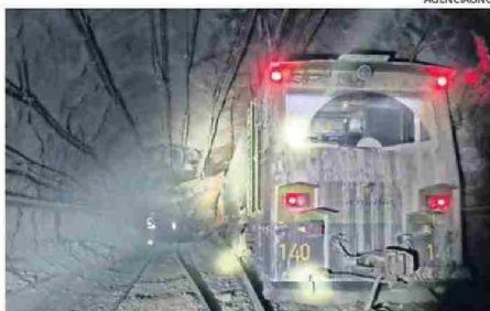
SE DETUVO REMOCIÓN DE ESCOMBROS EN EL PROYECTO ANDESITA.
