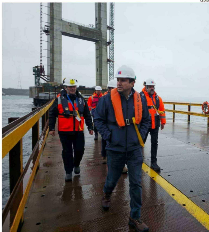
‘EL PROYECTO DEL PUENTE CHACAO TIENE EL ÁNIMO DE AVANZAR CON SEGURIDAD’, DIJO ROSENDE.
