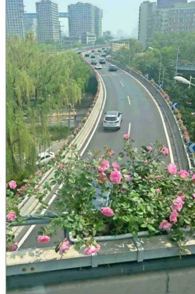
Este cruce de autopistas en Beijing muestra algunos elementos paisajísticos que integran la infraestructura vial al entorno.
