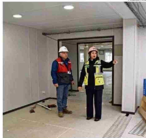
LA SEREMI DEL MOP EXPLICÓ ALCANCES DE LAS OBRAS EN AERÓDROMO.
