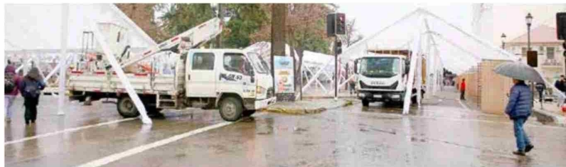
La calle 1 Poniente, a la altura de la Plaza de Armas y la 1 Norte hasta la 3 Oriente, ya están cerradas y en ellas se observaron ayer los últimos trabajos del encarpado.
