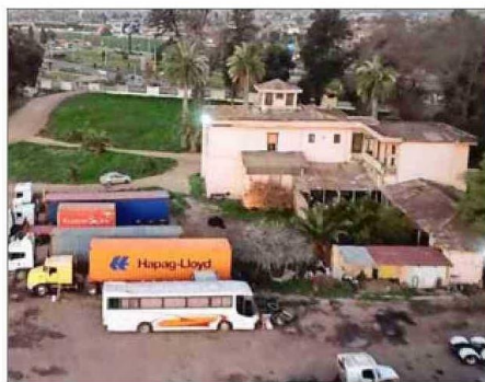
DESCUIDADA. — Se observa el deterioro y descuido de la casona.
