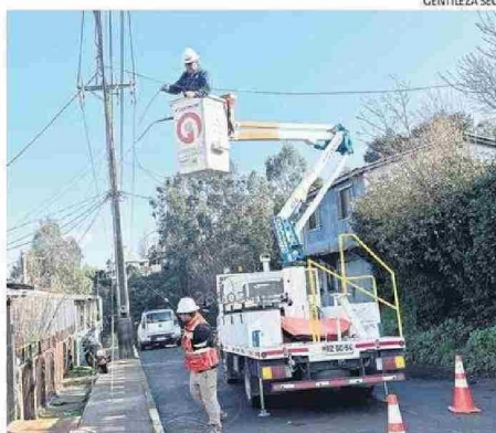
TRABAJOS DE REPOSICIÓN DE LOS SUMINISTROS ELÉCTRICOS.
